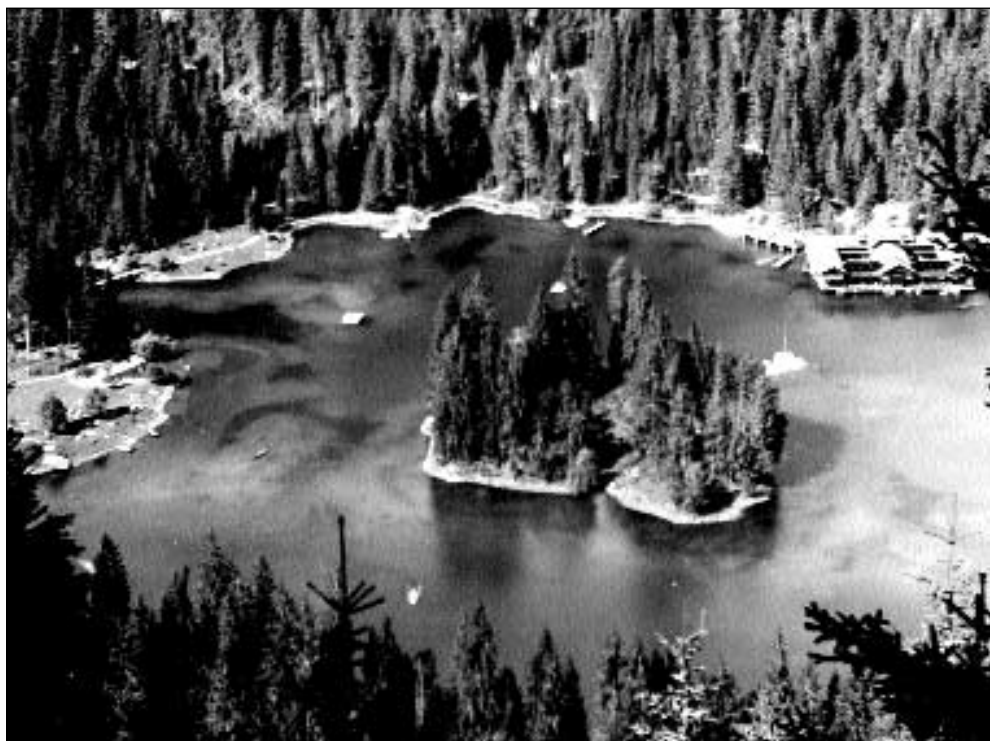
La foto sveglia nostalgia: Igl onn 1972 han ins disfatg il vegl baghetg da bogn al lag la Cauma. Il project da Valerio Olgiati füss staus treis gadas pli pigns.
